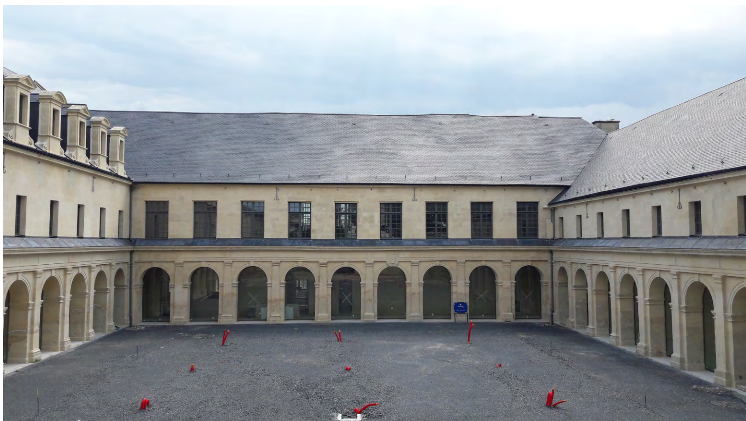
Chantier du FRAC Normandie Caen (juin 2017) © FRAC Normandie Caen
