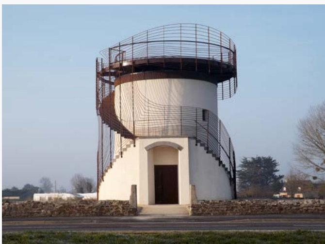
Le Belvédère des Ondes , Jean-Luc Vilmouth, 2012. Saint-Benoît-des-Ondes (35), action Nouveaux commanditaires. Réhabiliter un moulin en référence au paysage maritime de la baie du mont Saint-Michel.
