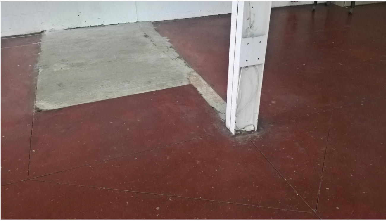
IPN 1 et reprise béton.
