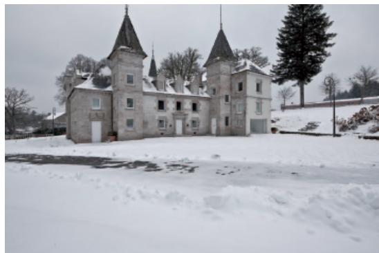
Notus Loci , réhabilitation du Château de Vassivière par les architectes Berger&Berger et BuildingBuilding photo : Thomas Raynaud
