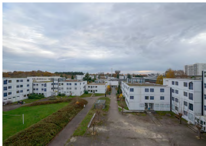
Lycée et collège de jeunes filles , cité scolaire de la Source, actuellement lycées Voltaire et Gauguin - Les internats vus depuis le bâtiment L © Région Centre-Val de Loire, Inventaire général, François Lauginie
