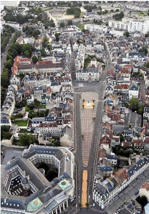
Aménagement de la place Saint-Sauveur pour la préfiguration de sa piétonisation
