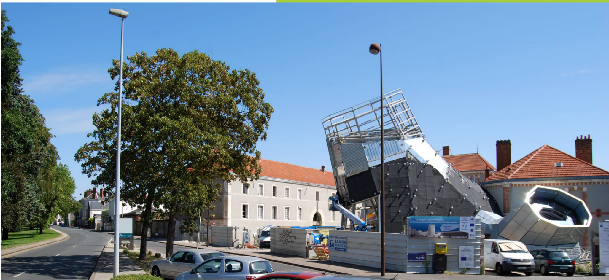
Chantier du FRAC Centre, juillet 2011, Orléans © Jakob+MacFarlane Photo—FRAC Centre
