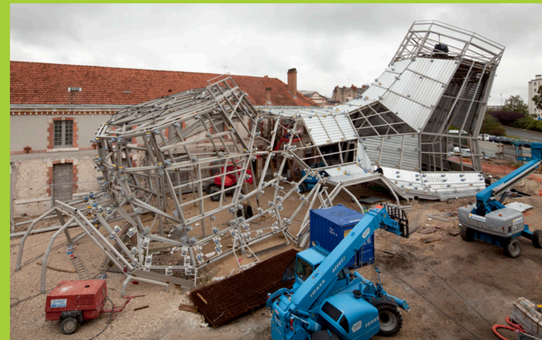
Chantier du FRAC Centre, juillet 2011, Orléans © Jakob+MacFarlane Photo—Nicolas Borel
