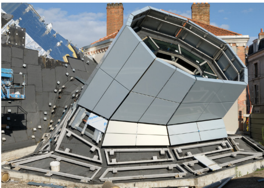
Chantier du FRAC Centre, août 2011 © Jakob + MacFarlane Photo—F. Lauginie
